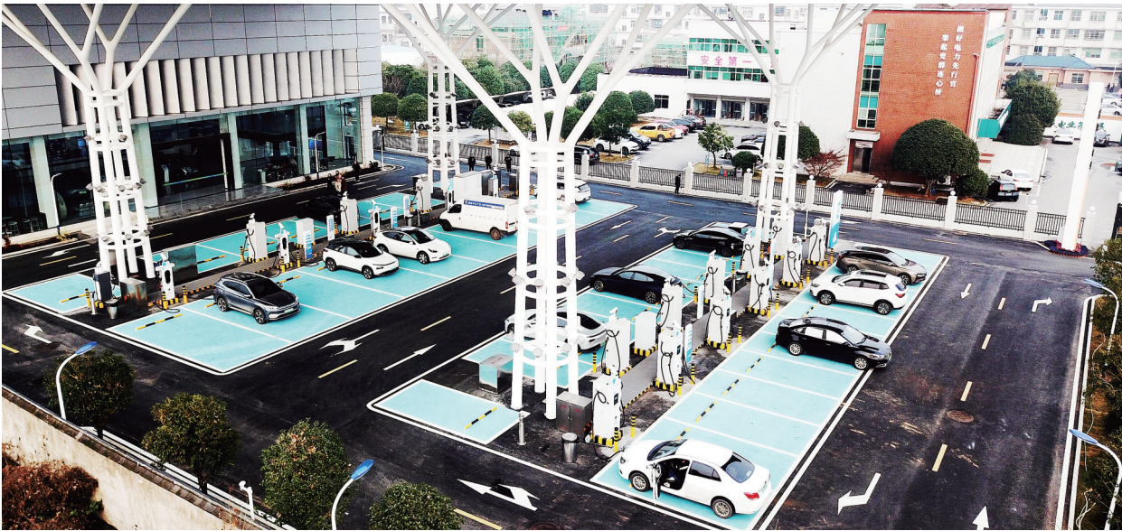
这是位于长沙市长沙县的一家集“光伏+储能系统+液冷超充+车辆检测”功能于一体的充电站。(资料照片) 新华社记者陈振海 摄
