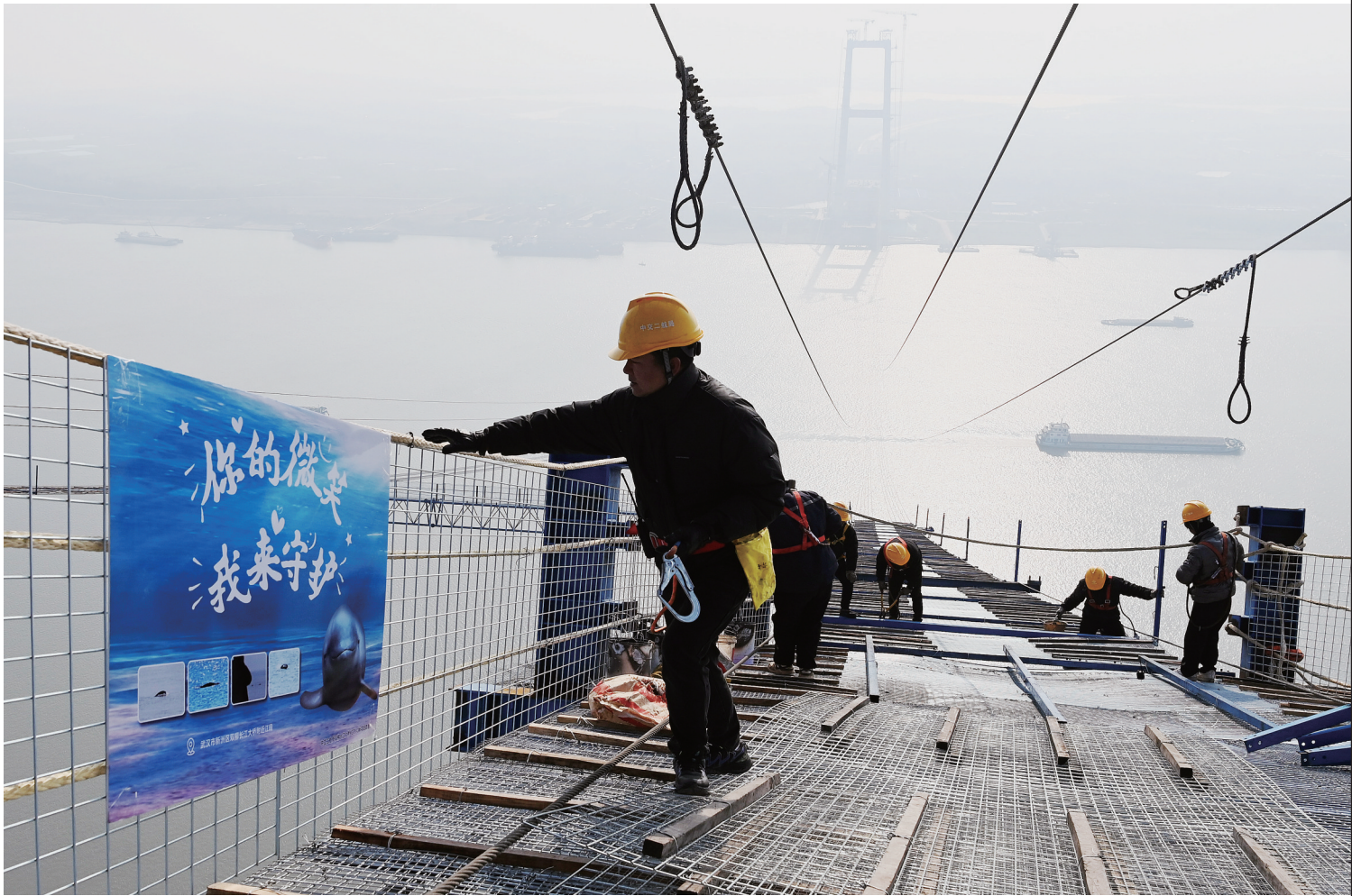
2024年12月13日，双柳长江大桥猫道铺设现场，一块“你的微笑我来守护”长江江豚保护宣传牌，格外醒目。
