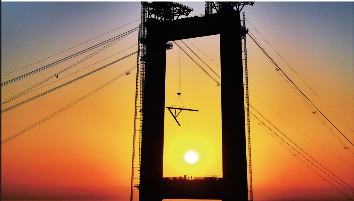
2024年11月28日7时17分，太阳刚刚升起，大桥施工人员赶在长江江豚出没高峰时段错峰施工。
