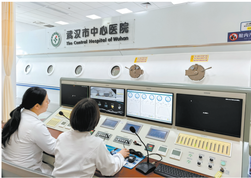
武汉市中心医院杨春湖院区高压氧治疗中心。
