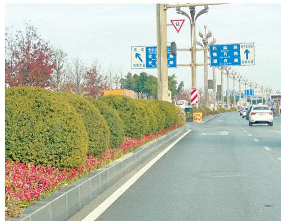
高新大道上一处主辅路并线口前,主辅路之间的绿化带较高,遮挡视线。
