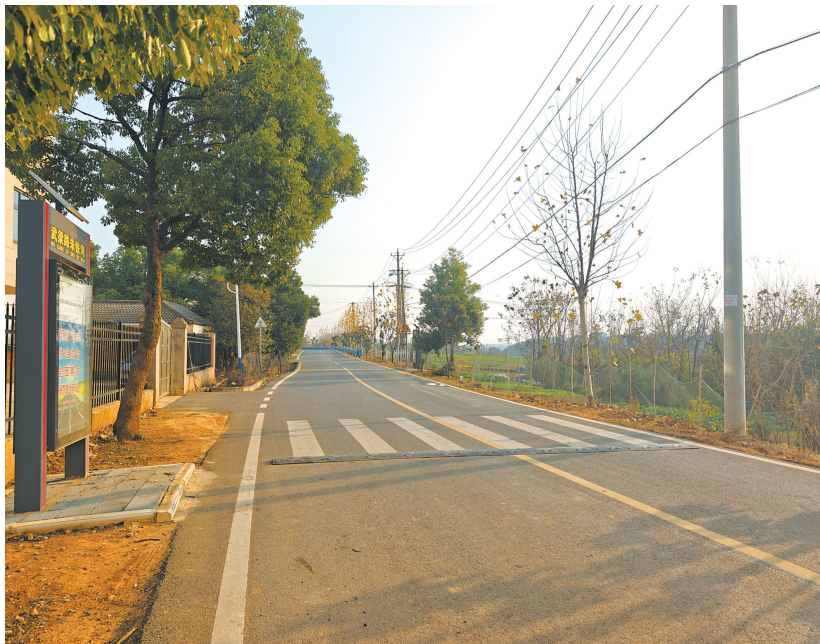
武梁路朱铁湾站旁的黑色减速带。
