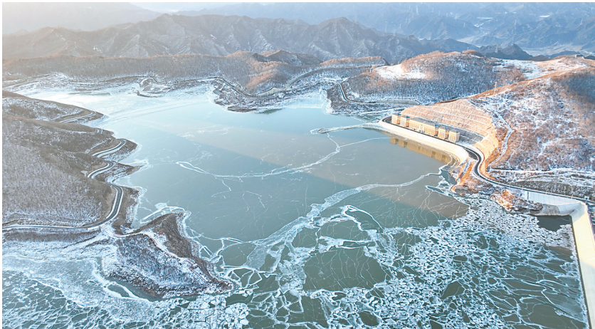
国家电网河北丰宁抽水蓄能电站上水库。
