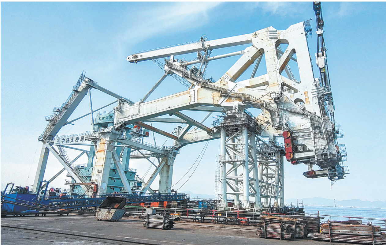
全球首艘可倒伏式中心起吊起重船。
