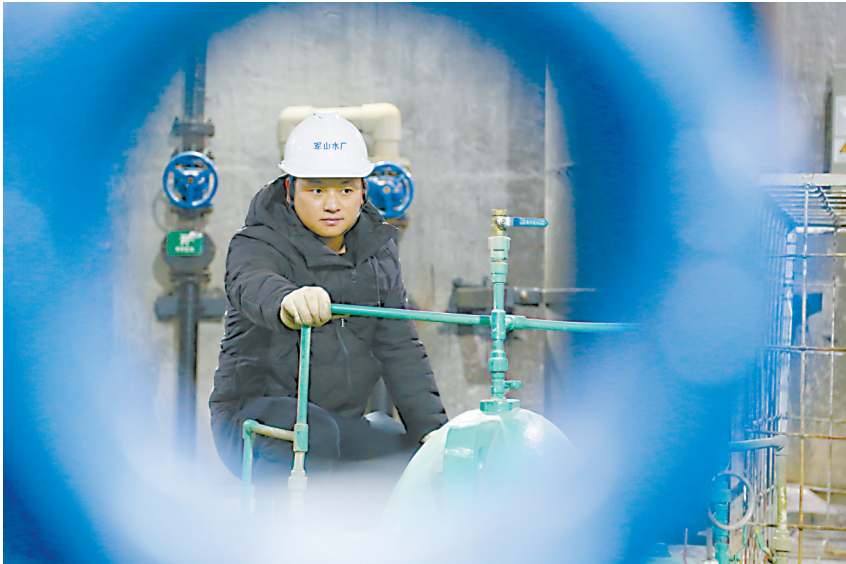
史登贵来到深达26.3米的取水井筒,查看设备运行情况。
