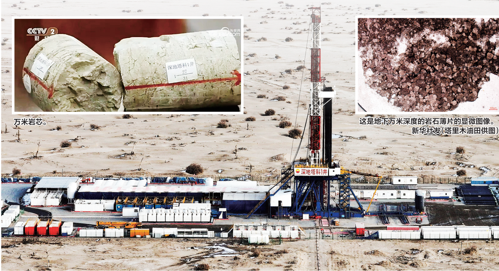
这是2月19日在新疆塔克拉玛干沙漠腹地拍摄的中国石油塔里木油田深地塔科1井(无人机照片)。
