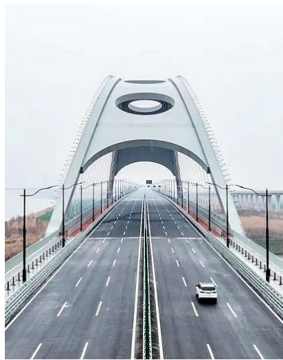
左岸大道(港口二路至华科大军山校区段)通车。通讯员李涛 田钰杰 摄
