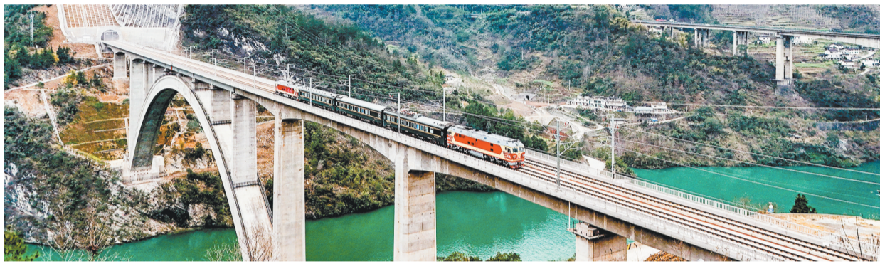
3月9日，新建渝厦高铁重庆东至黔江段启动联调联试，通车运营进入倒计时。
