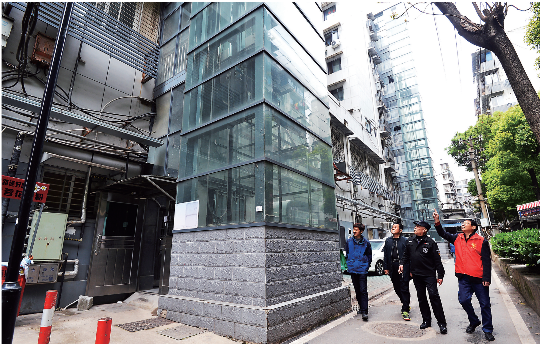
8层楼的老房子安装新电梯解决了爬楼难的问题。
