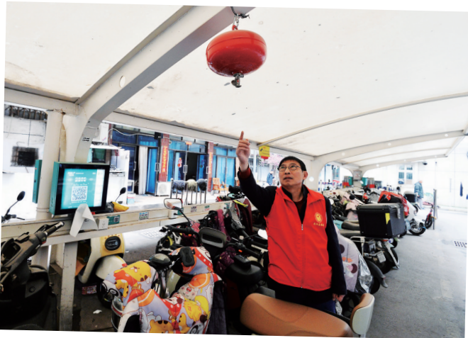
电动车棚里装了灭火弹。
