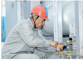
吕更生安装设备。
