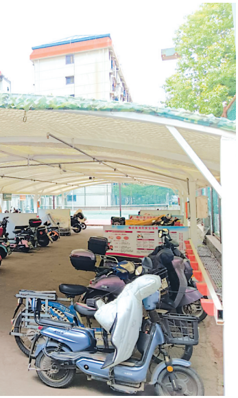
改造后的电动车棚。
