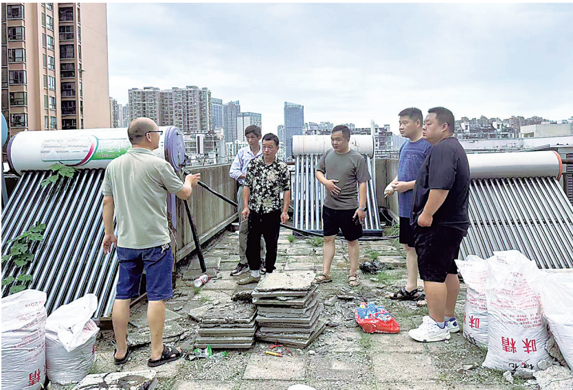
楼顶漏水治理。
