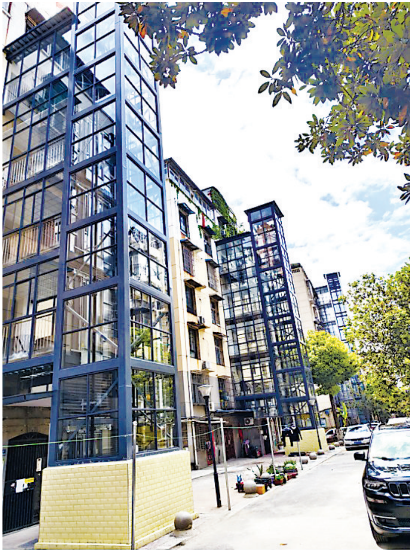
电梯建设完成,成为小区一道亮丽的风景线。
