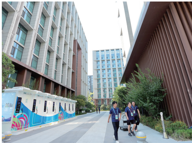
这是8月3日在成都世运会运动员村A区拍摄的参赛者公寓区。
