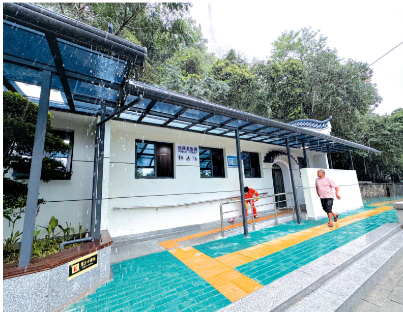
△市政盲道延长至公厕内部,方便特殊群体。
