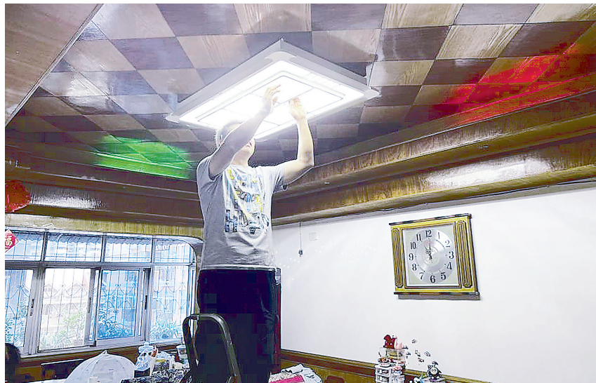
马家社区志愿者裴桂华义务为有需要的家庭维修电灯。
