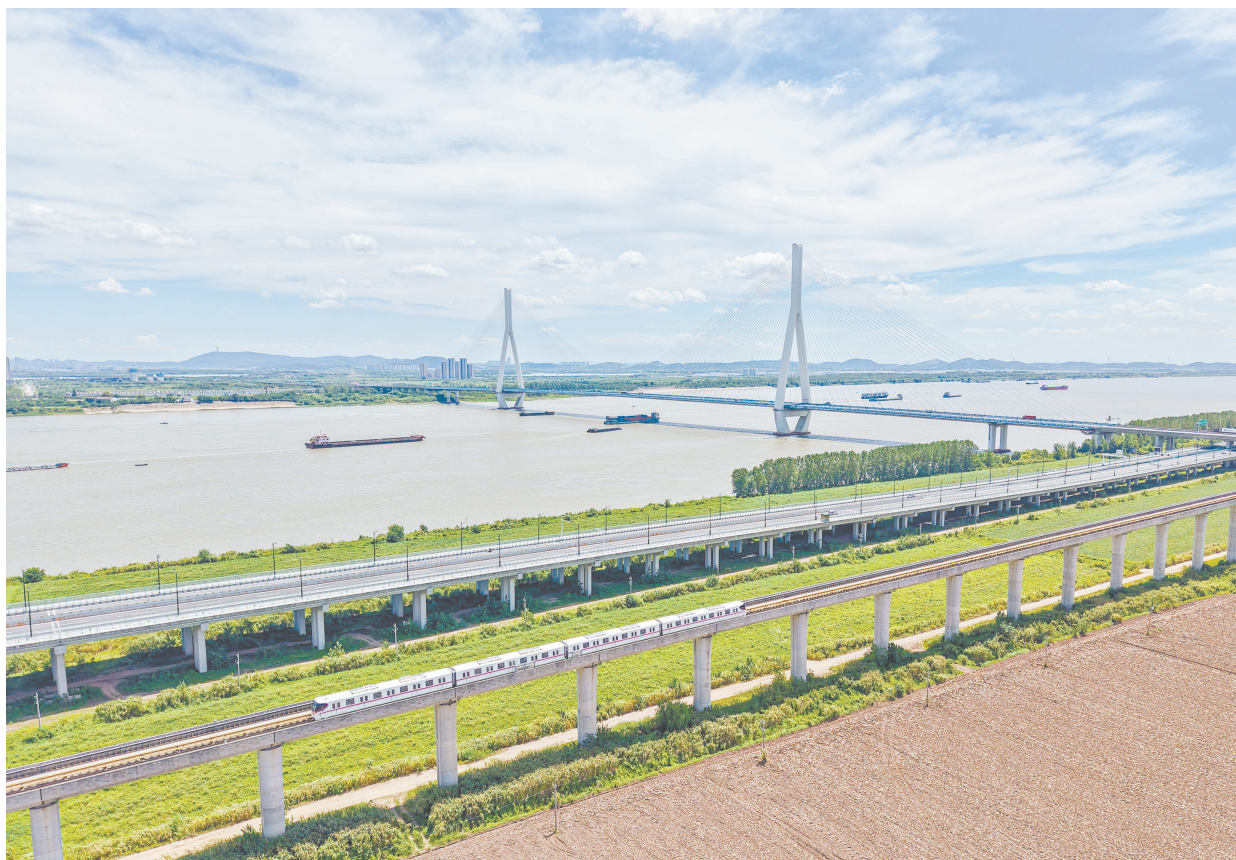
8月20日上午,武汉经开区左岸大道(沿江大道)22公里全线贯通。
