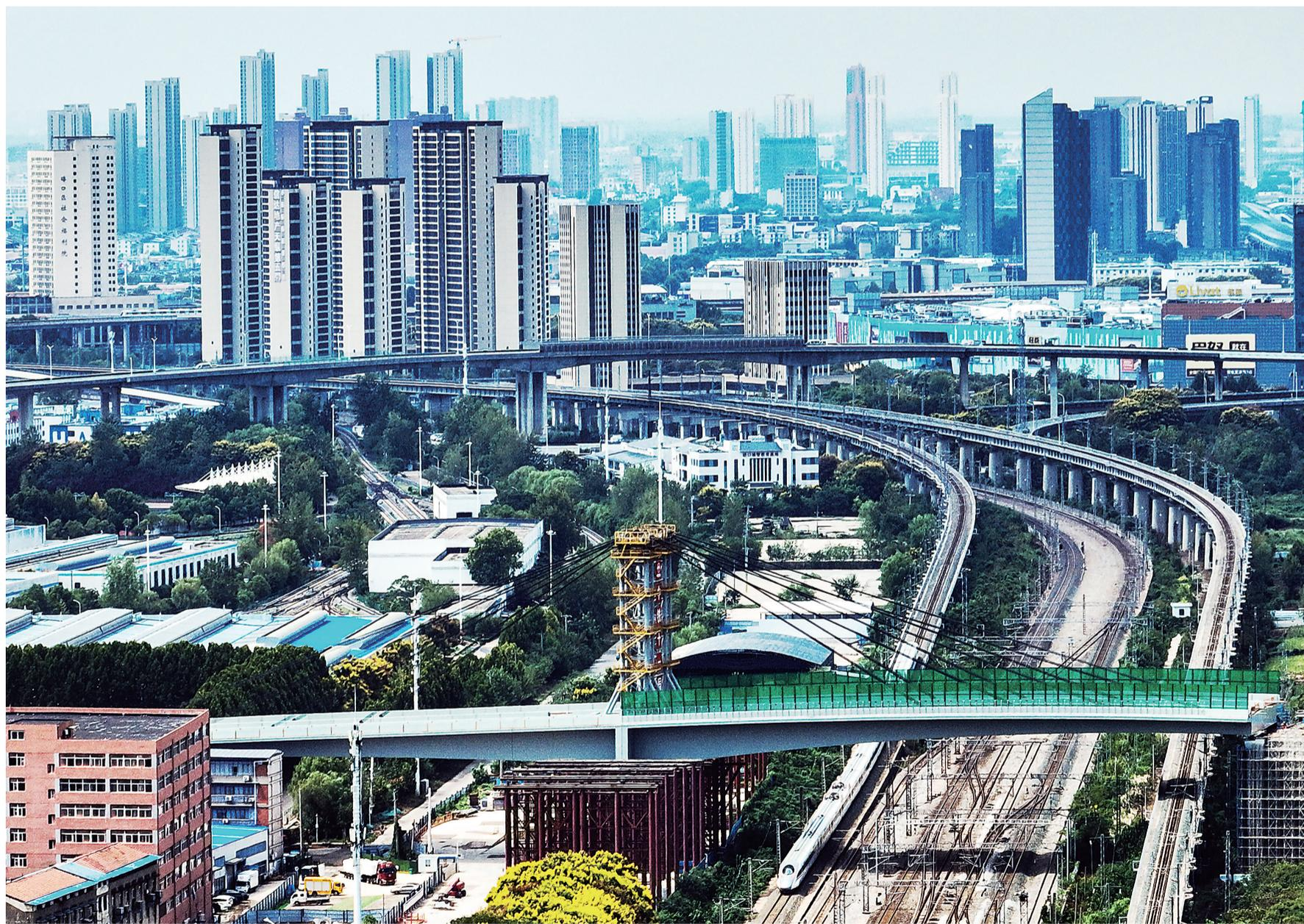
桥体成功转体后,列车从桥体下方驶过(9月11日摄,无人机照片)。9月11日,由湖北交投集团投资、中铁十一局集团承建的武汉市古田一路北段工程跨铁路立交桥成功转体,桥体平稳逆时针旋转81.7度,实现毫米级高精度对接。据了解,古田一路北段项目预计2025年底主桥建成通车,将有效疏通城市交通“堵点”,实现硚口区与东西湖区的快速联通。
