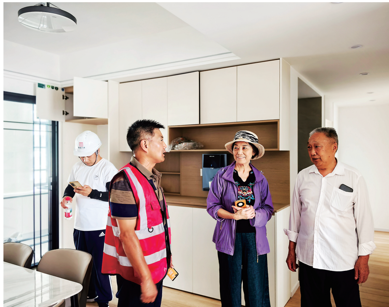
燃气管道改造过程中,多方实地沟通。
