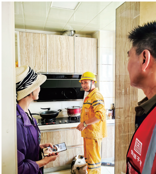
燃气管道改造“一户一策”现场沟通。
