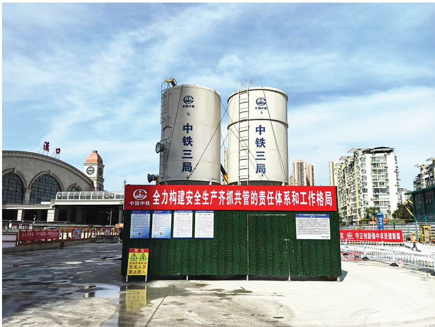
施工场地干净整洁。
