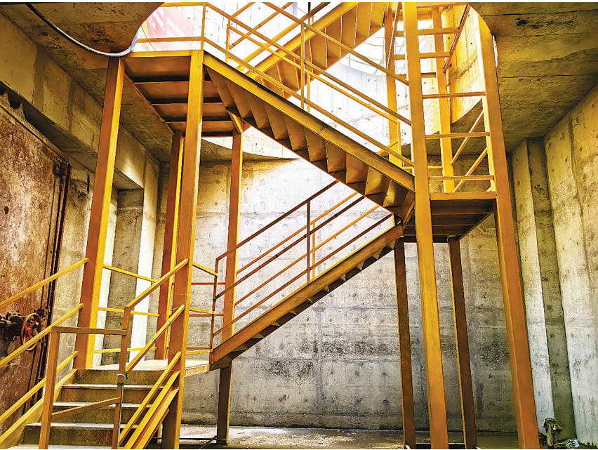
上下基坑通道设置标准化。
