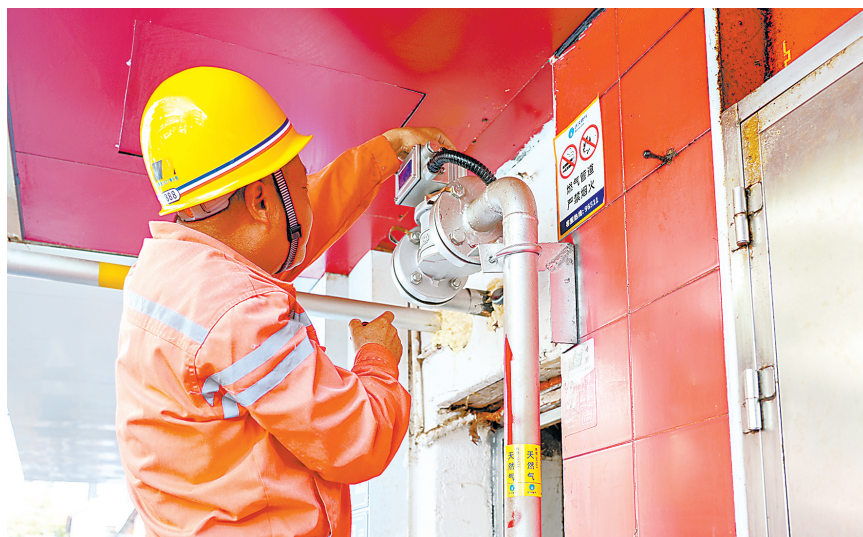
天然气公司施工人员安装管道设施。
