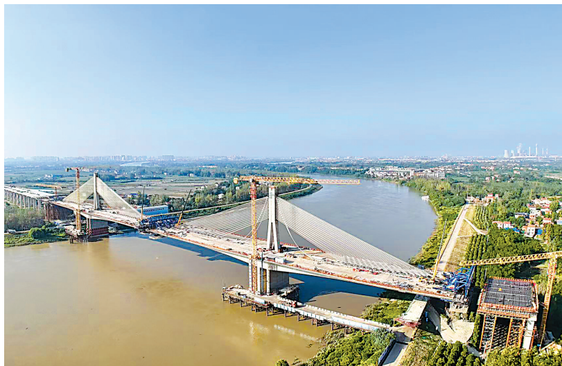
武天高速马口汉江特大桥即将合龙。
