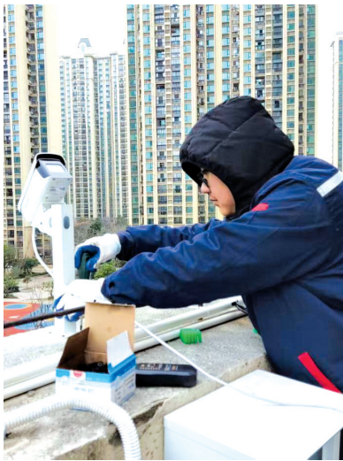
工作人员安装高空抛物监控摄像头。
