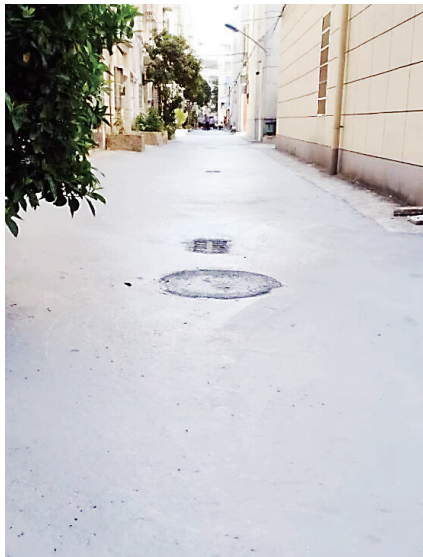
铺设下水管后新修的道路。
