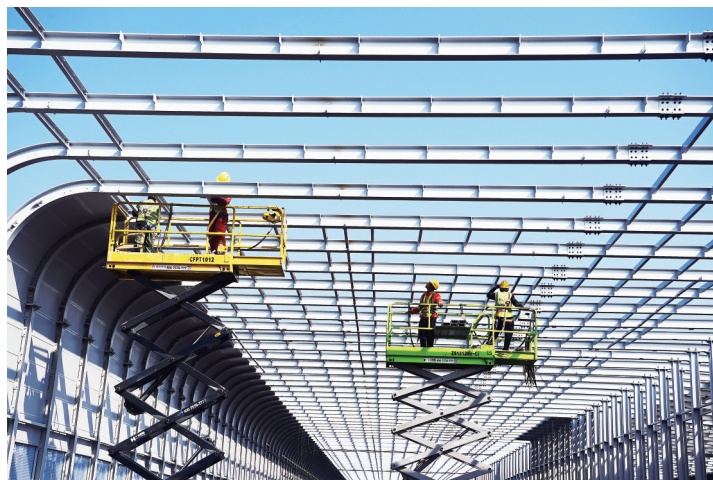
工人师傅们正在对全封闭式声屏障的主体进行检查。
