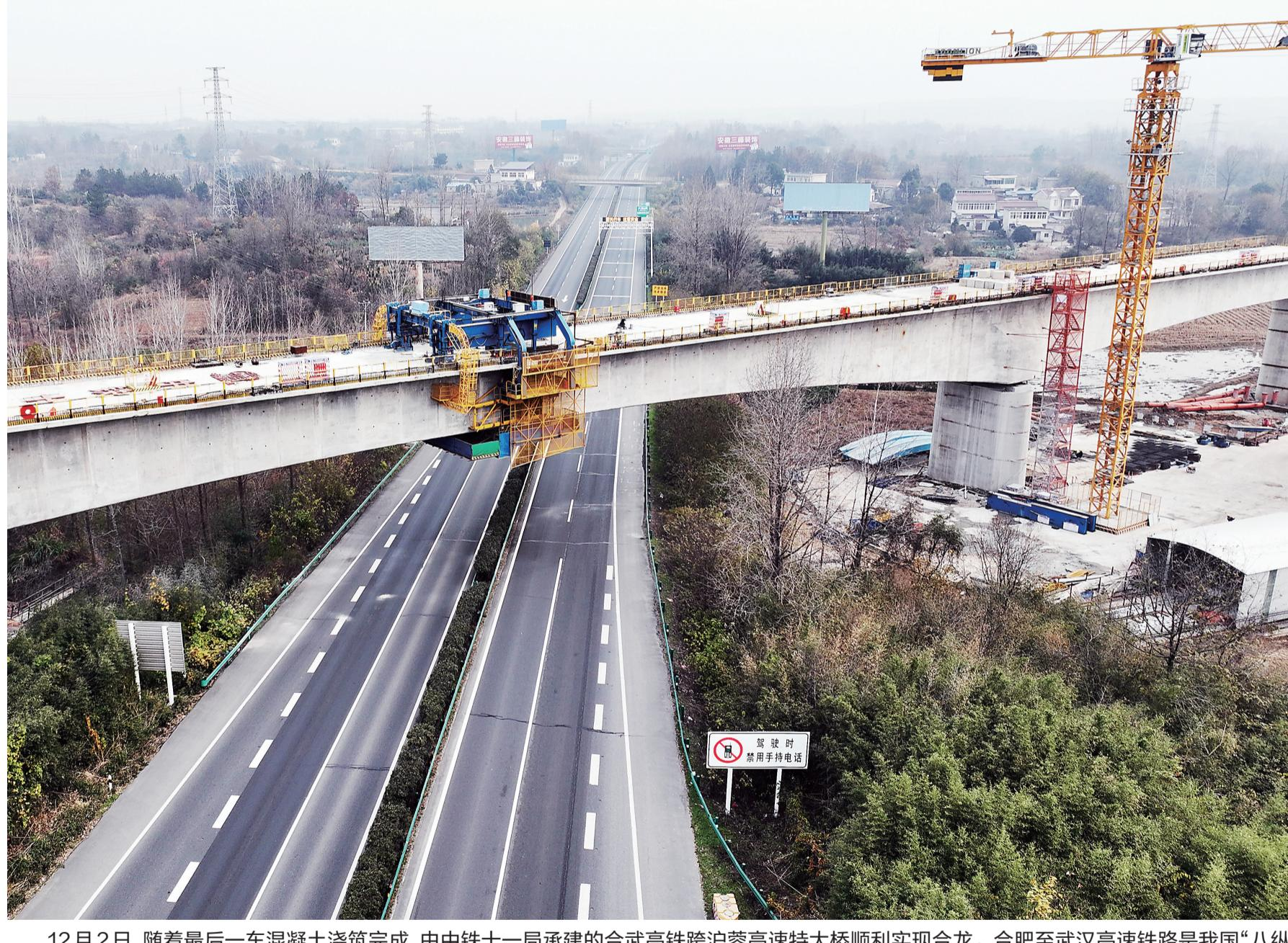
12月2日，随着最后一车混凝土浇筑完成，由中铁十一局承建的合武高铁跨沪蓉高速特大桥顺利实现合龙。合肥至武汉高速铁路是我国“八纵八横”高铁网沿江通道的重要组成部分，设计时速350公里。线路建成后，将在合肥至武汉间形成新的高铁大通道，进一步优化长江经济带铁路网布局。图为合龙后的合武高铁跨沪蓉高速特大桥（无人机照片，12月2日摄）。
