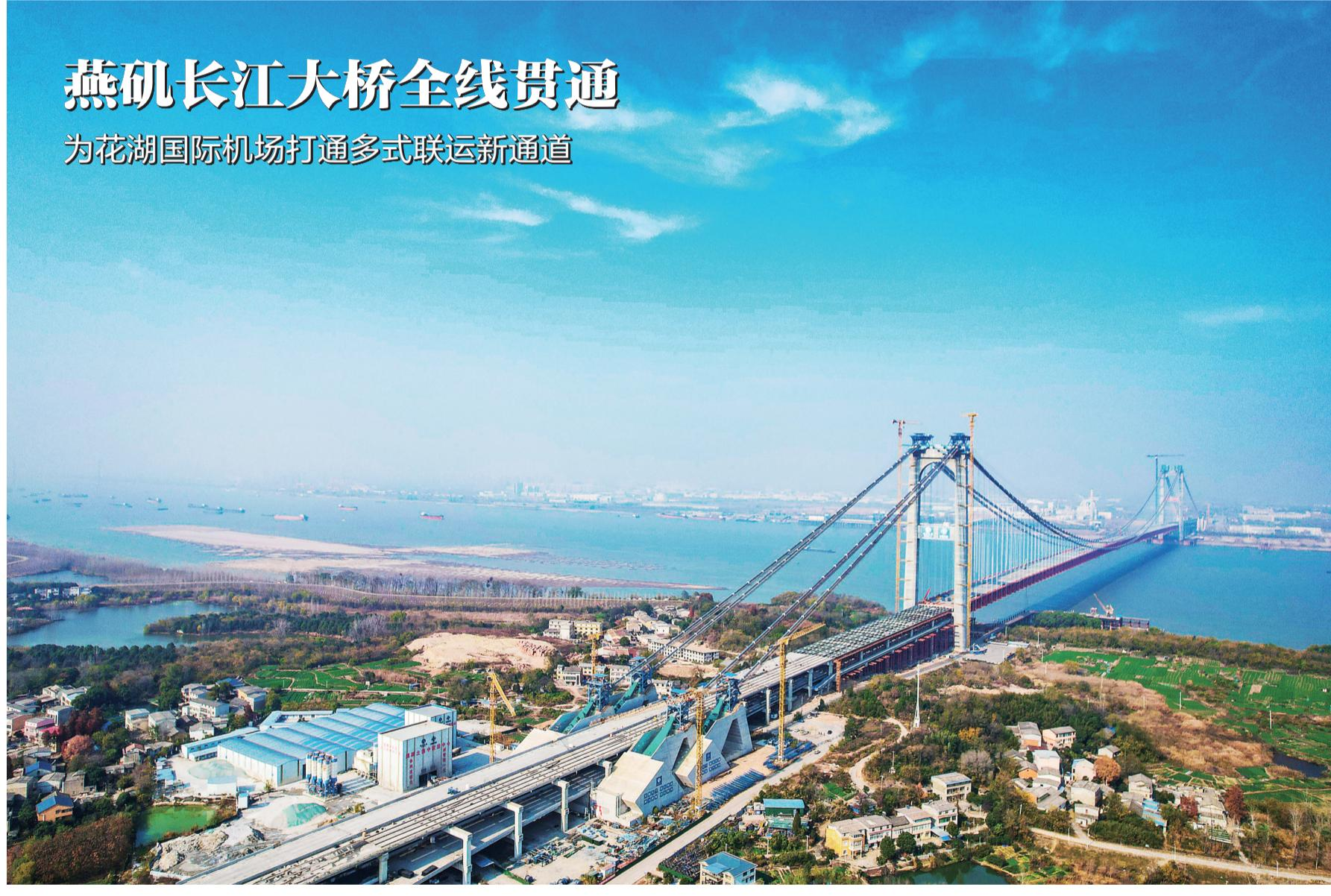
12月7日,随着燕矶长江大桥鄂州侧引桥最后一榀钢混组合梁精准吊装到位,标志着湖北交投投资、中交二航局承建的湖北燕矶长江大桥实现全线贯通。燕矶长江大桥横跨鄂州、黄冈两地,采用一跨过江的方式,是世界最大跨径四主缆悬索桥。
