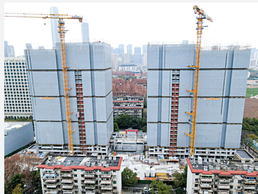
湖北大学危旧改造项目南区工地项目进程。
