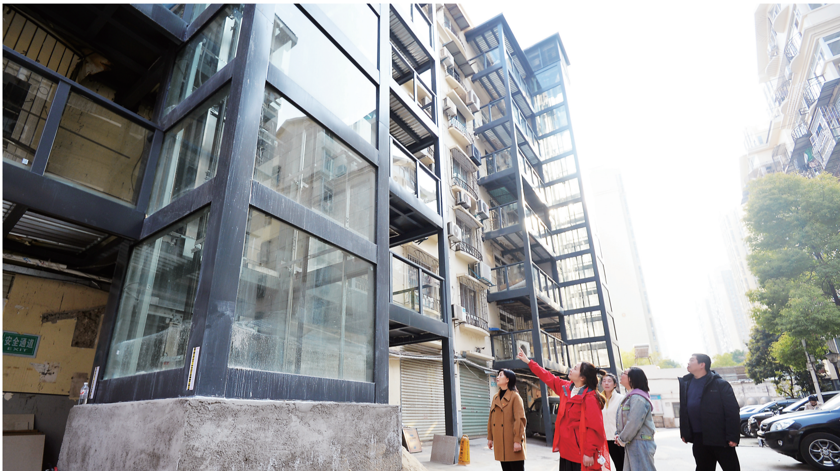
老旧居民楼加装的新电梯在春节期间开始投入使用。
