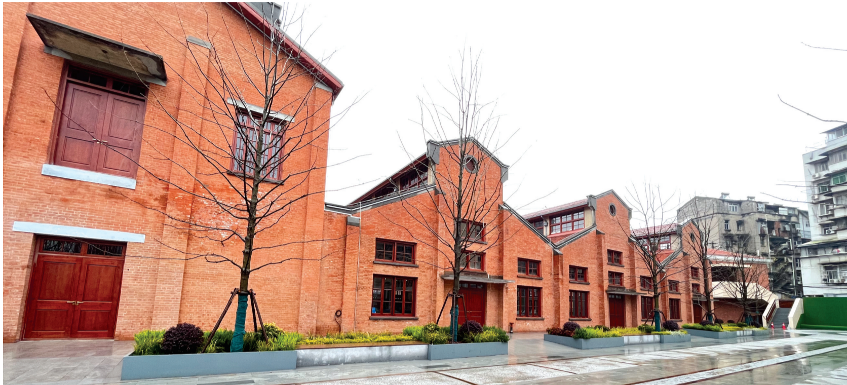
已完工的3号楼。
