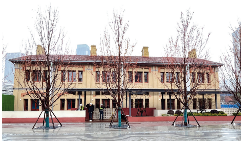
已完工的2号楼。
