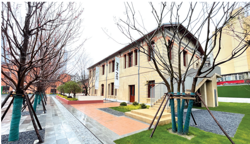
已完工的1号楼。
