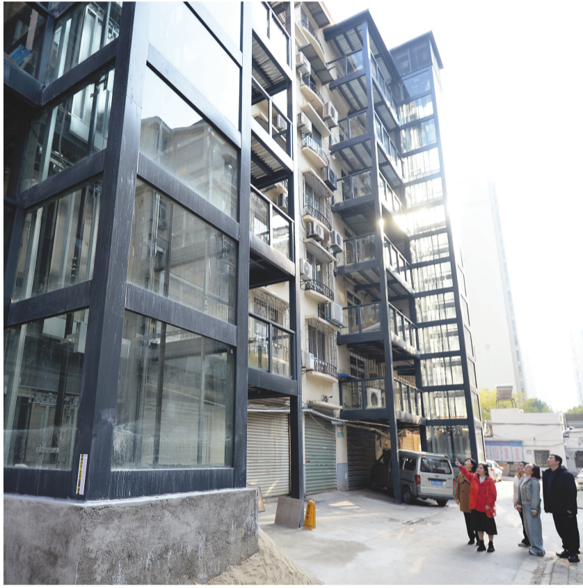
社区工作人员与居民现场查看新安装好的电梯。
