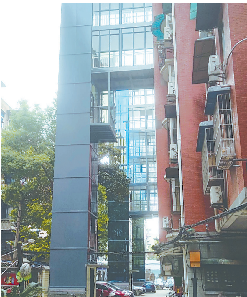
小区加装电梯,居民下楼更便利。
