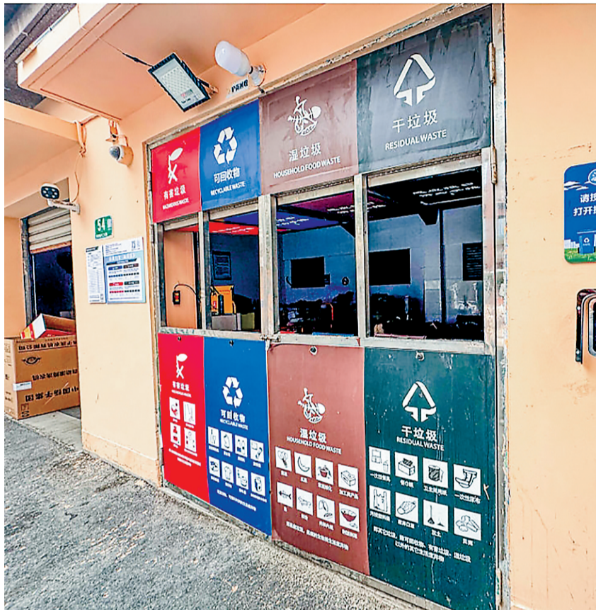
一老旧小区内,智能垃圾箱的感应投放口处于常开状态。
