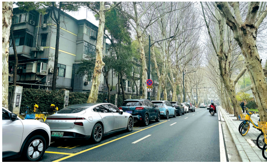
光华路机动车道维修,晚上打围施工,白天恢复通行。 记者陶常宁 摄
