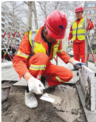
施工人员在基层均匀涂布新型快速黏结剂。
