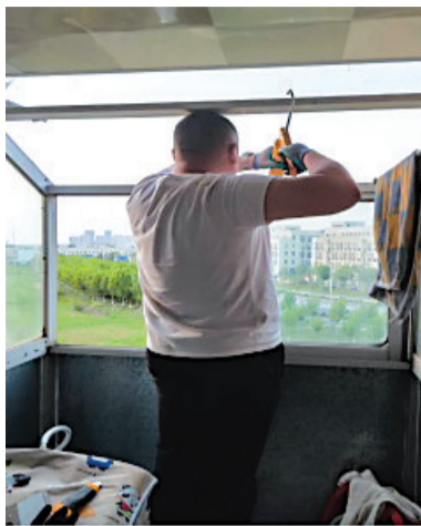
检查窗户受损情况。
