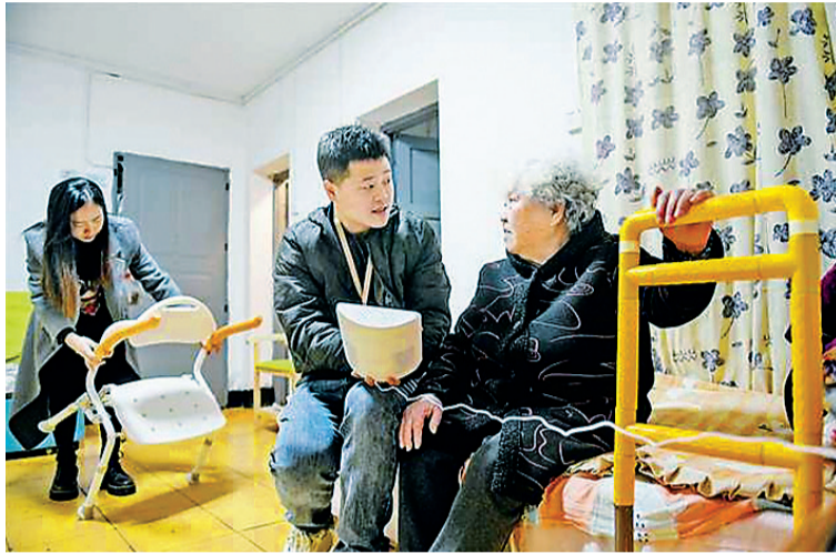
实施适老化改造的工作人员为82岁的老人安装床边扶手。
