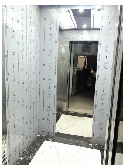
电梯更新完成。
