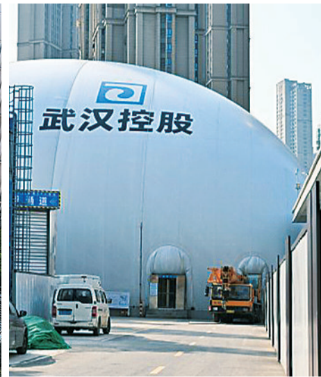
基坑气膜外,施工现场整洁干净。
