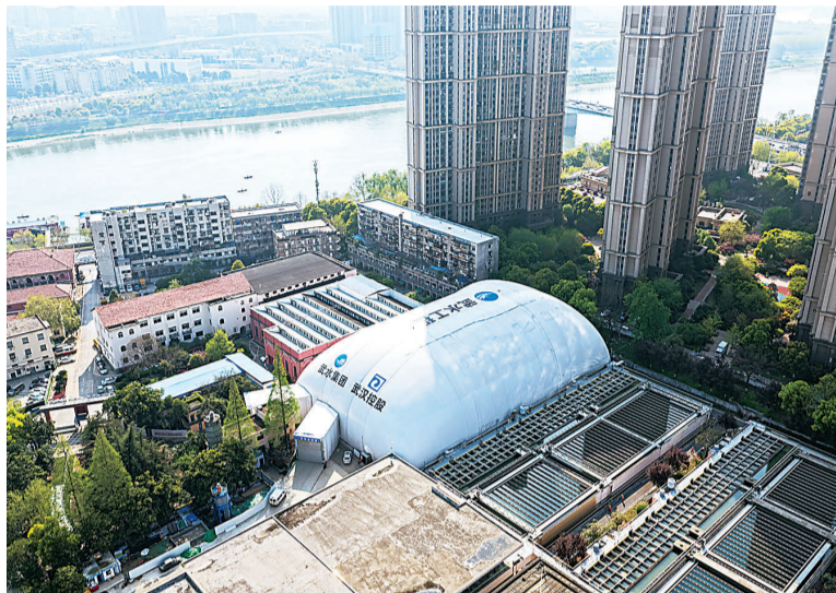
空中俯瞰,宗关水厂基坑气膜如同一只巨大的白罩子。
