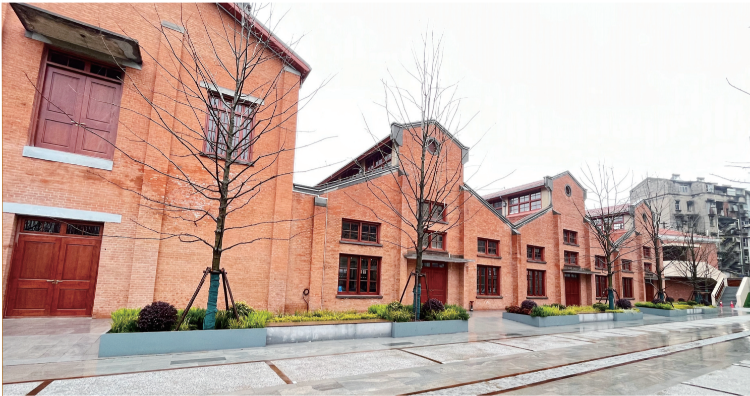
刚保护修缮完工的3号楼。
