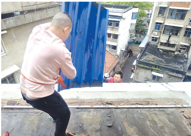
工作人员拆掉遮阳棚找漏点。
