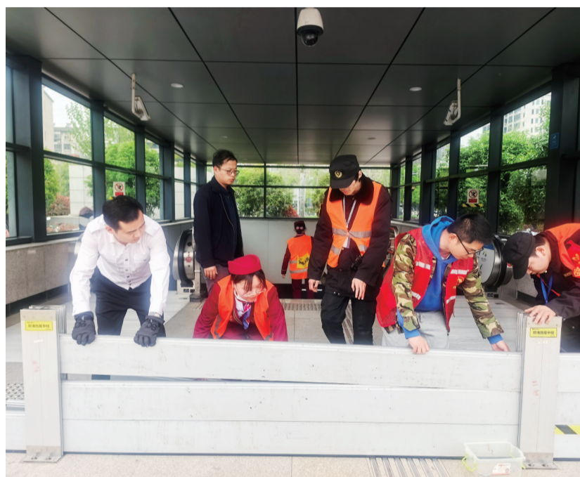
临漳社区应急队队员与地铁工作人员共同组装固定防洪挡板。
