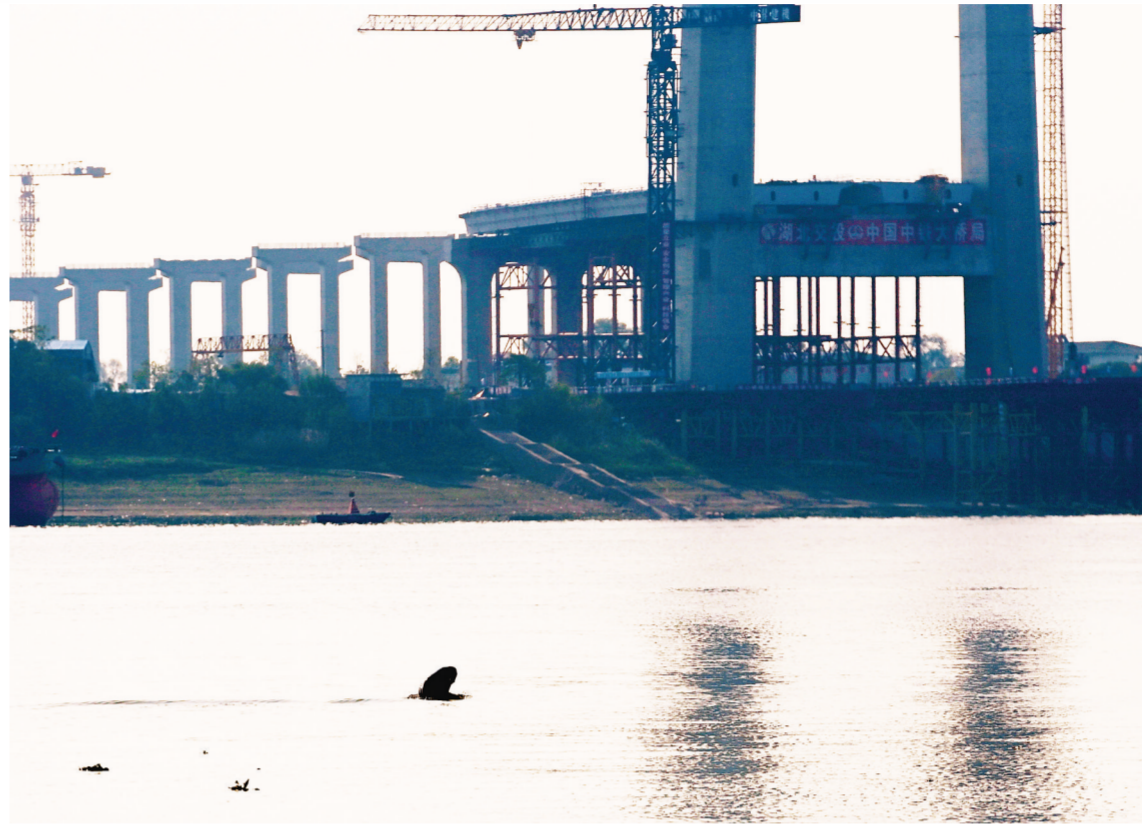
为了不打扰江豚的生活,建设武汉双柳长江大桥时不在江中打一根桩。 记者金振强 摄
