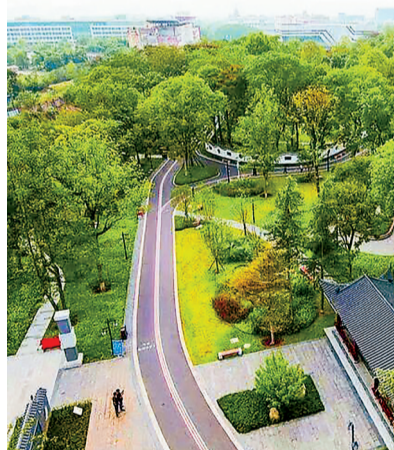
绵阳经过海绵城市改造后的透水路面干净整洁、雨水花园生机盎然。
