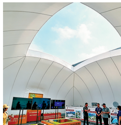
具有防尘、降噪作用的基坑气膜技术。
