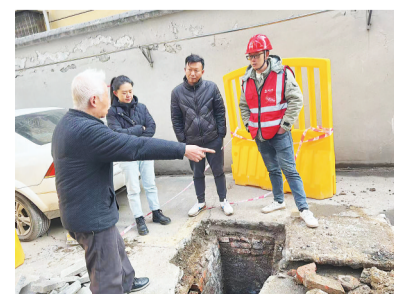
居民参与排污管道改造。
