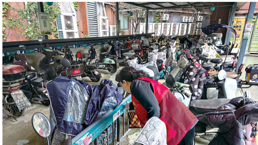
小区党员正在检查电动车停车棚的充电桩使用情况。记者冷靖华 摄
