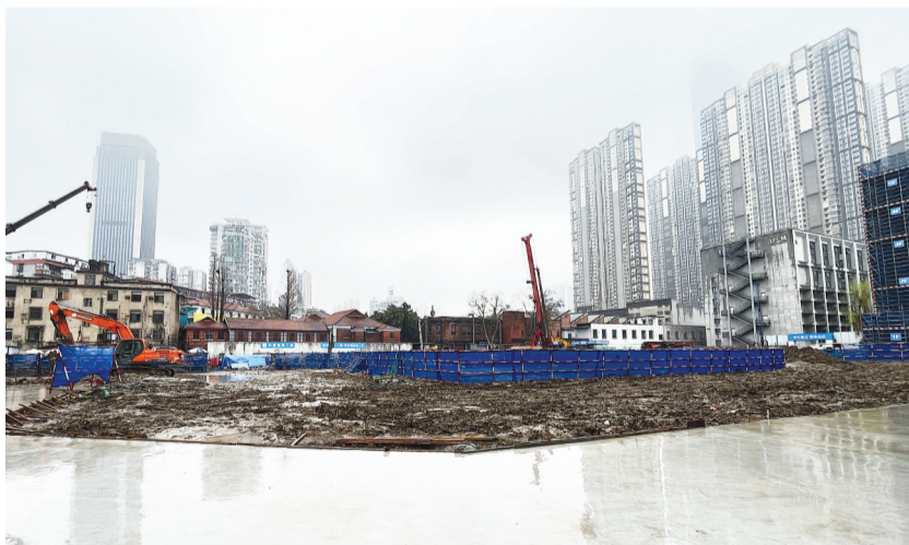
地下停车场正在加紧施工。
